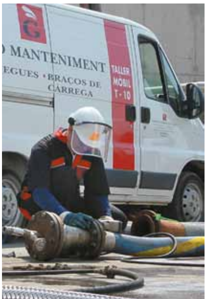
Mantenimiento y reparación. Repairs and maintenance.
