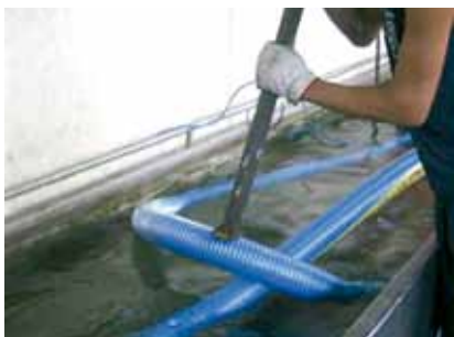
Prueba de presión. Pressure test.
